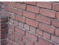
foto 8: terugliggende baksteenlaag
