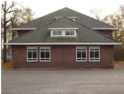
foto 2: schilddaken, zwarte dakpannen
