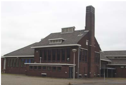
foto 3: kantine en keukengebouw
