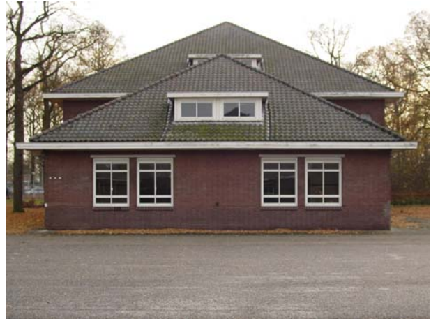
foto 2: schilddaken, zwarte dakpannen
