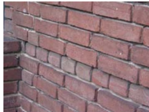
foto 8: terugliggende baksteenlaag
