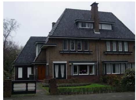
foto 4: villa op het Bolwerk
